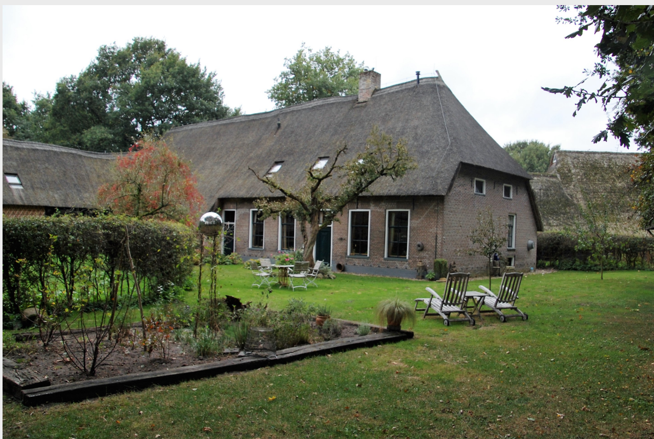
Dorpsstraat 1 vanaf de achterzijde
